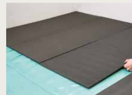
PLACAS DE AISLAMIENTO QUICKHEAT Placas de aislamiento. 120 × 50 × 0,7 cm. 10 placas/paquete. 0,6 m 2 /placa, 6 m 2 /paquete. Grosor: 7 mm. Se recomienda utilizar una barrera contra el vapor. Coloque la película de PE PGUDLSCREEN34 debajo de las placas de aislamiento QuickHeat y encima de las láminas QuickHeat.
